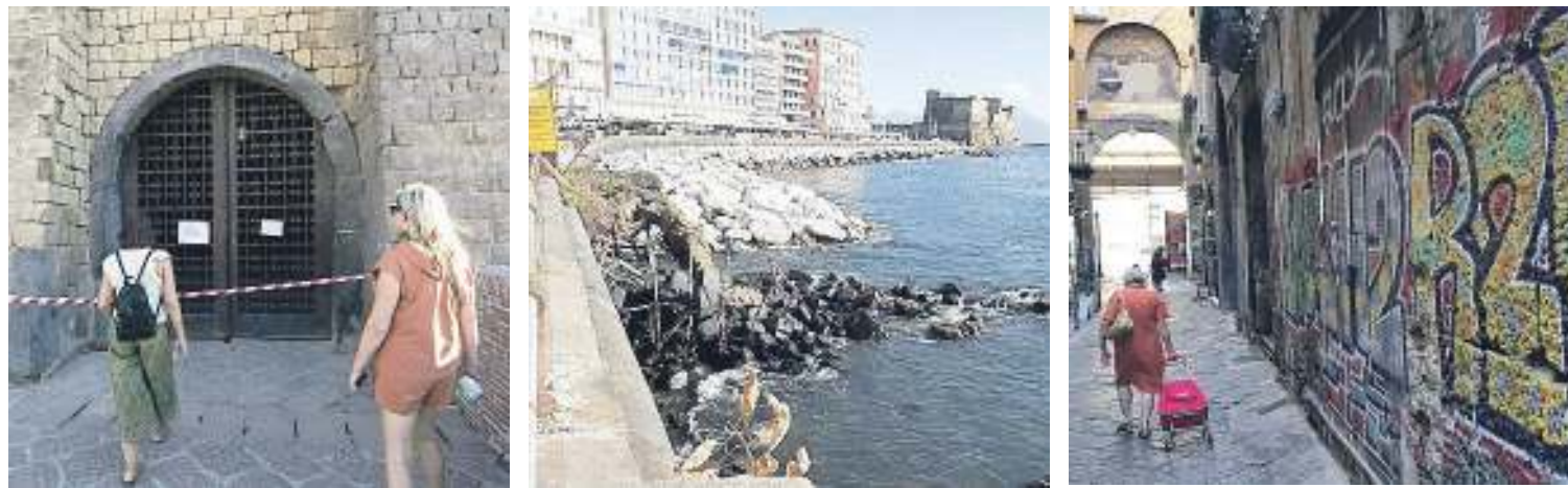
EMERGENZE Da sinistra: Castel dell'Ovo chiuso per cedimenti dalla facciata, Arco Borbonico crollato, centro storico sfregiato dai murales
